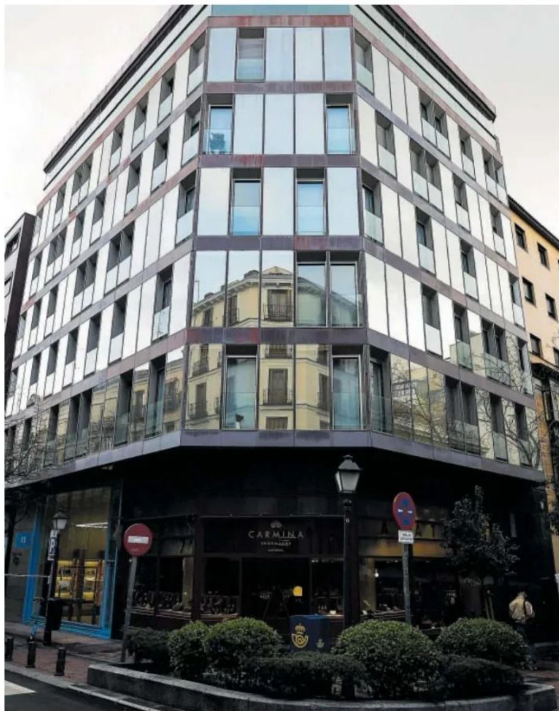
Fachada en la calle de Claudio Coello 73, en Madrid. SAMUEL SÁNCHEZ
